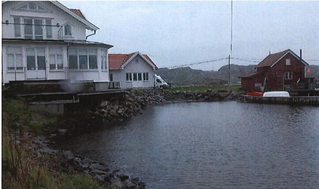
Bild tagen från klippor utvisande baksidan av garaget.
