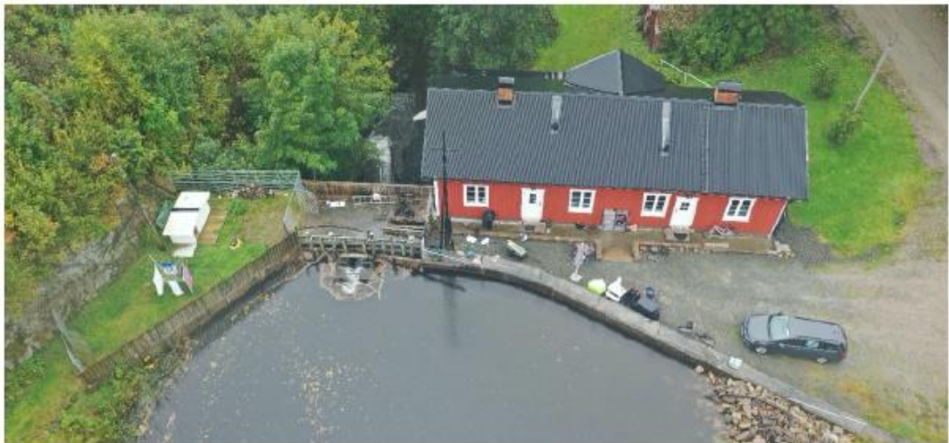
Västra Stigen kraftverk sedd från uppströmssidan.
