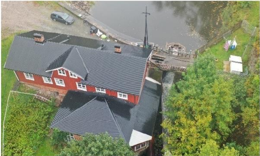
Västra Stigens kraftverk sedd från nedströmssidan. Sick-sacköverfallet syns uppströms utskovet.
