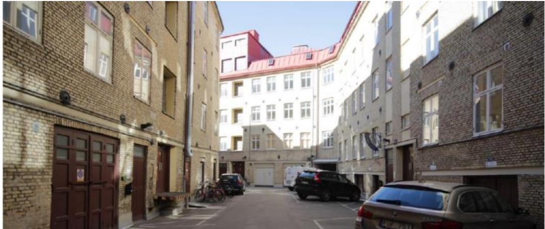
Den västra gårdsbyggnaden till höger i bild, den östra till vänster. Ur Antikvarisk bedömning(2018).
